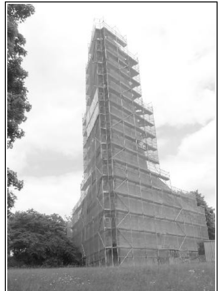
Die Christuskirche mit Baugerüst bei ihrer ersten umfassenden Sanierung.
